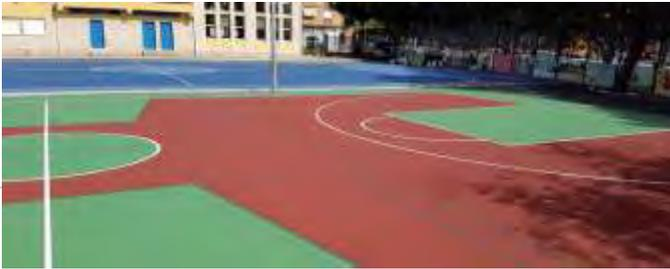
La superficie GreenSet MULTISPORT consiste en varias capas superpuestas de materiales compatibles y complementarios: una capa de preparación de PREBASE (cuando la sub-base es de asfalto) o de BONDING COAT (cuando la sub-base es de hormigón o es una superficie existente), una capa de BLACK BASE, una capa de COLOR BASE, una capa de FINISH y las líneas de juego LINE.
